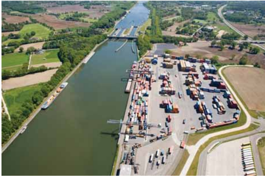
Figure 50: Vue aérienne du terminal de Meerhout (Source: Euroports)
